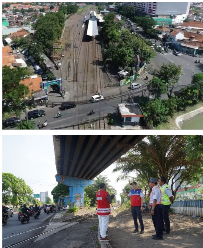
Gambar 4. 15 Stasiun Wonokromo tampak atas dan Perlintasan di bawah Flyover Mayangkara
