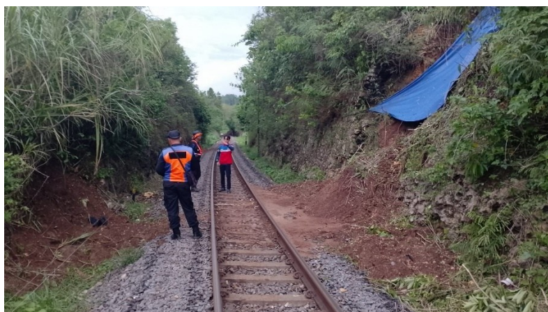
Gambar 4. 23 Longsor Lereng antara Sumberpucung – Wlingi Km. 81+000 s.d Km. 104+000
